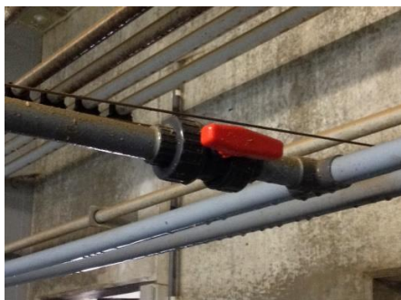
aansluiting PVC-leiding
